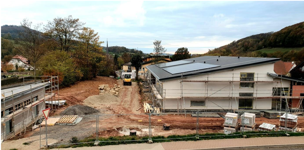
Der Stand der Bauarbeiten für die neue Kindertagesstätte im Oktober 2019
